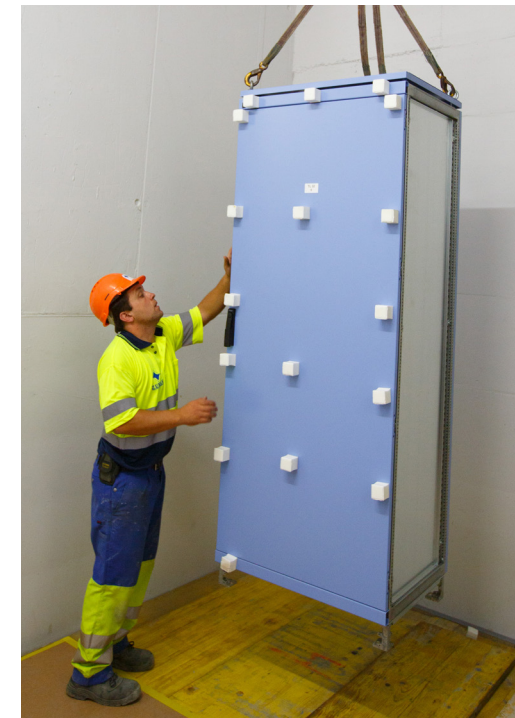
● A Grosshüs, les armoires sont hissées à l'aide d'une grue.
