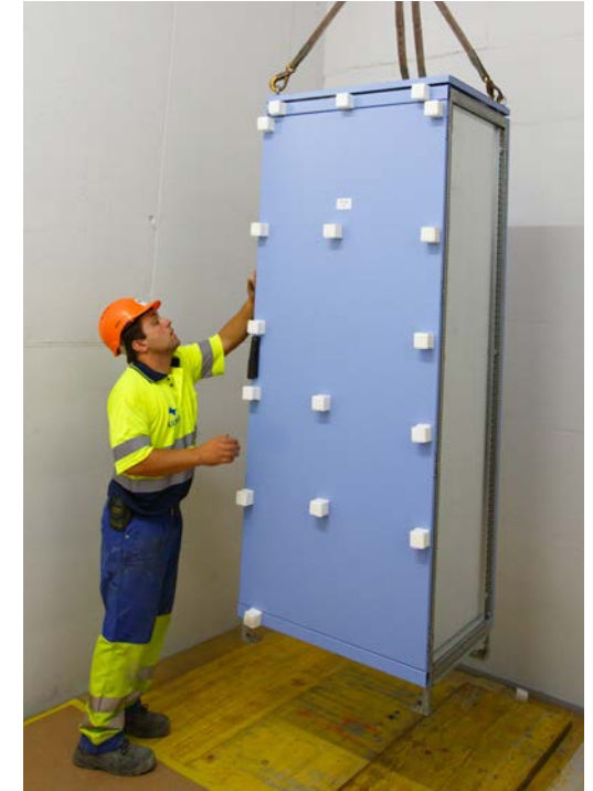
● Mit einem Kran werden die Schränke in Grosshüs nach oben gezogen.
