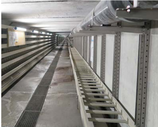
● Im Werkleitungskanal Tunnel Eyholz werden 950 Schaltgerätekombinationen eingebaut.
