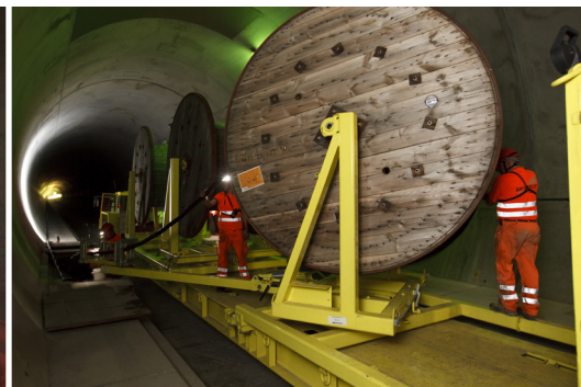
● Transport der grossen Bobinen auf dem MFF.
