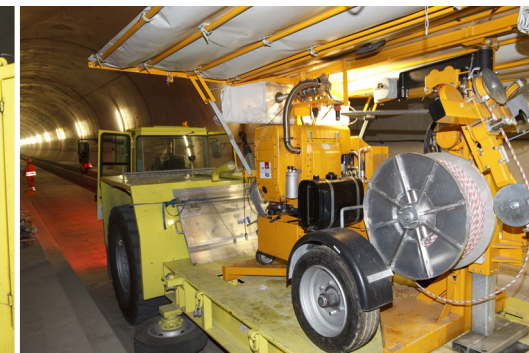
● Kabeleinzug in die Bankette ab MFF.
