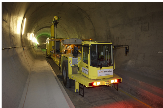
● Hebekran für schweres Gerät auf dem MFF.
