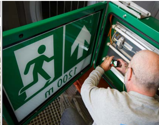
● Ruag prüft Signalisationen auf Wasserdichtheit.
