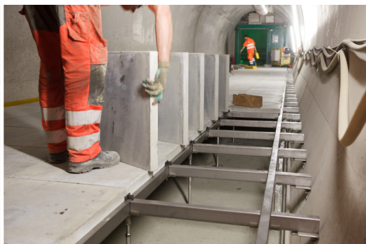
● Einsetzen der Platten auf die Unterkonstruktion.
