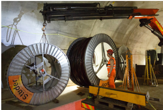
● Das MFF bringt die Bobinen in den Tunnel.
